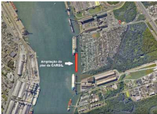
Figura: Terminal da Cargill em construção
