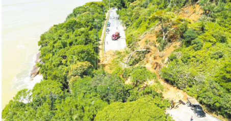
No km 61 da Rodovia Rio-Santos, na Praia do Lambert, em Ubatuba, deslizamento chamou atenção
