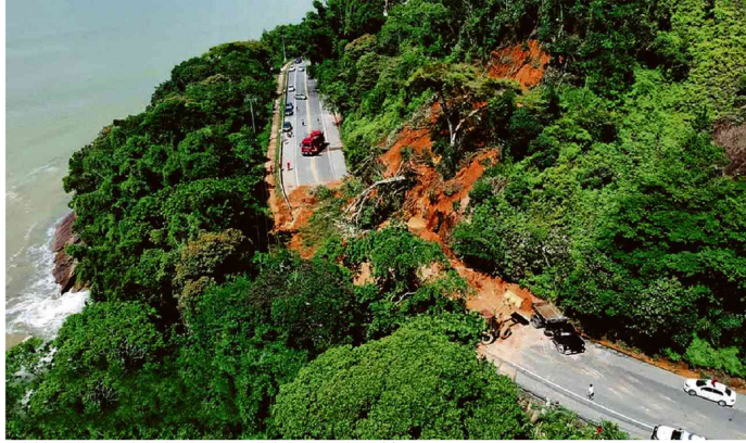
Queda de barragem bloqueia trecho da rodovia Rio-Santos, na região de Ubatuba, neste domingo (19) (Foto: Bombeiros, Divulgação)
