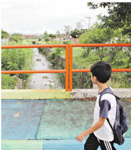
Garoto observa córrego canalizado no Jardim Yeda: obra foi sugerida pelos moradores do bairro
