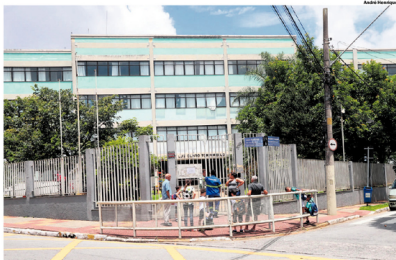
ACESSIBILIDADE. Professores e municípios alegam que elevadores de escolas municipais não estão funcionando
