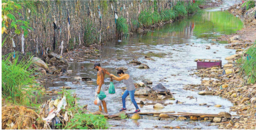
Casal atravessa o córrego Taubaté, no Jardim das Bandeiras, utilizando uma passagem improvisada pelos moradores, após a chuva ter destruído a ponte que existia no local
