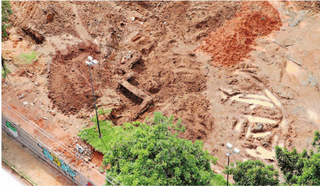
Durante trabalho de remoção de terra para construção de um novo reservatório subterrâneo de água da Sanasa foram encontradas ruínas da antiga Praça das Águas, datada do século 19
