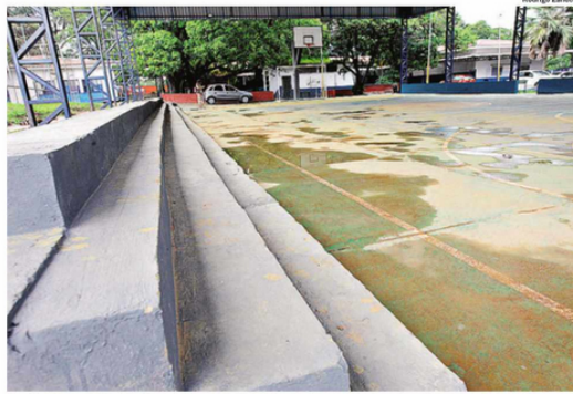
Quadra da escola Vicente Riso, no Parque Industrial: piso de concreto será trocado por um de borracha
