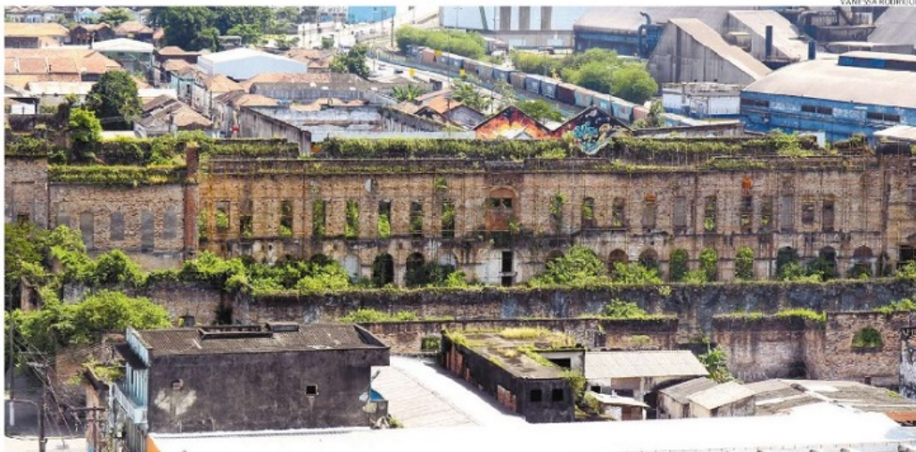
Construído em 1912, prédio não abrigou imigrantes; ao longo dos anos, foi depósito de alimentos e sede de empresas que consertavam navios
