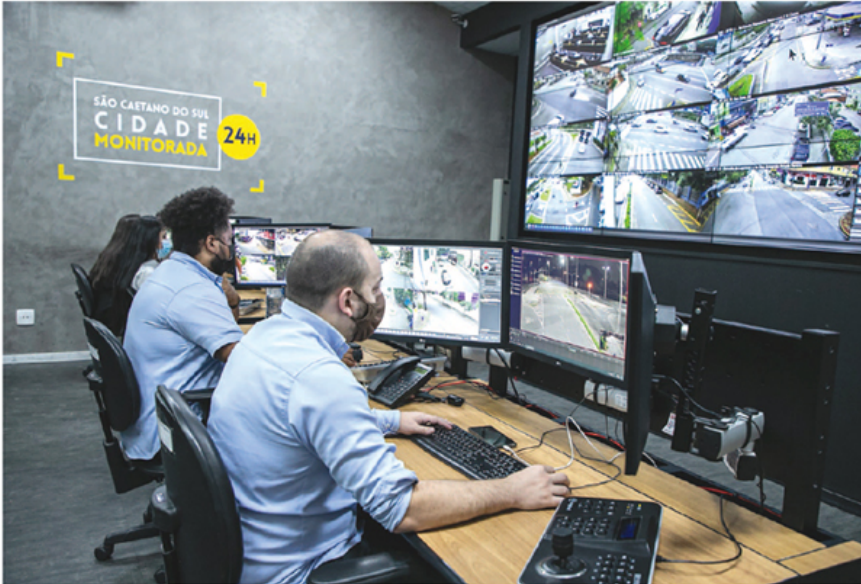
OPERADORA Claro entregará à cidade um sinal de última geração que permitirá uma maior agilização dos serviços públicos
