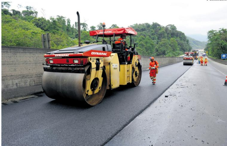
ASFALTO BORRACHA. Pavimento é produzido pela Ecovias com pneus recicláveis; 30 km do trecho Planalto será renovado
