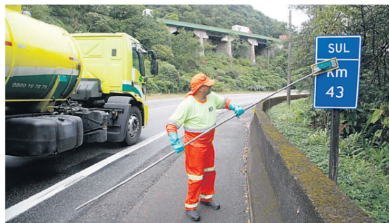
ROTINA. Só em 2022, colaboradores limpam mais de 10 mil placas e substituíram outras 250
