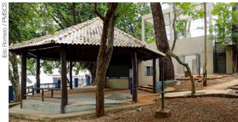
A obra, realizada pela Sesurb, foi iniciada no fim de dezembro e deve ser concluída em fevereiro
