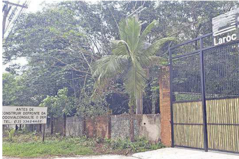
Casa de shows constrói pátio a poucos metros da estrada e da placa do DER alertando que não pode construir sem autorização
