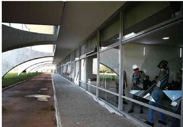
Funcionários instalam novos vidros nas janelas do andar térreo do Palácio do Planalto Pedro Ladeira/Folhapress
