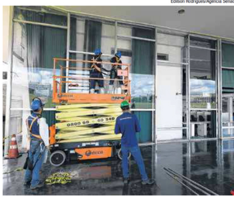
Trabalhadores, ontem à tarde, recuperavam janelas do prédio
