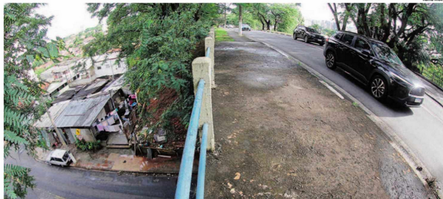
Trecho da Avenida Norte-Sul no acesso ao Taquaral: Amando de Queiroz Telles Coelho defende a construção de um segundo viaduto
