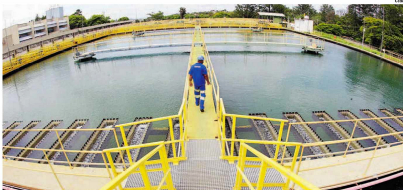
Estação de tratamento de água em Campinas: Amando Coelho atribui a qualidade do abastecimento ao projeto implantado em 1967
