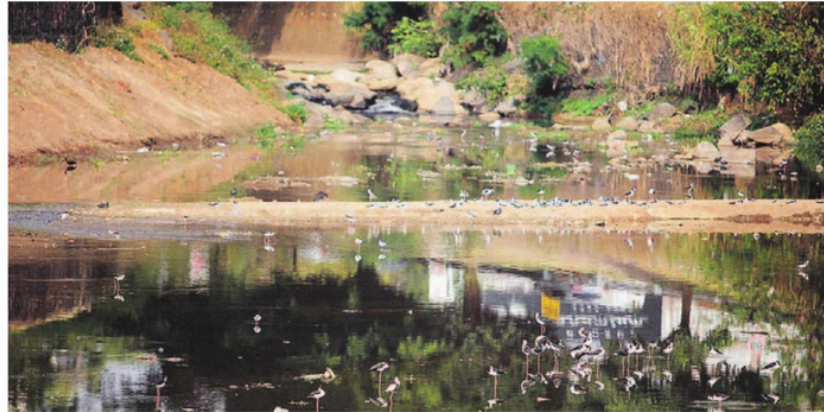
Piscinão da Via Norte-Sul, que será remodelado na primeira etapa do projeto de construção de novos reservatórios contra enchentes e inundações
