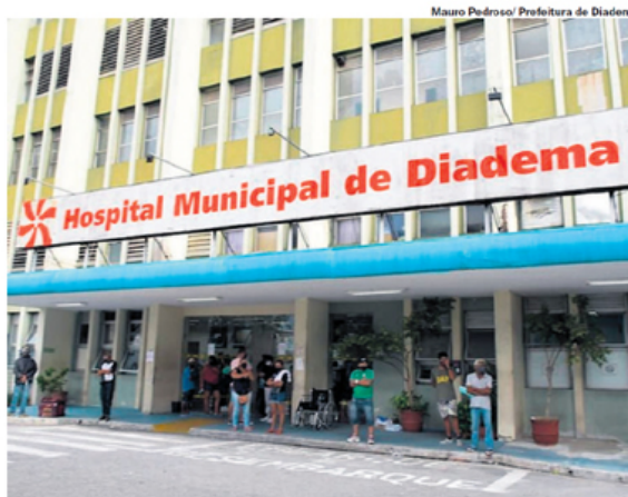
CUIDADO. Hospital restringe visitas para evitar contágios de doença
