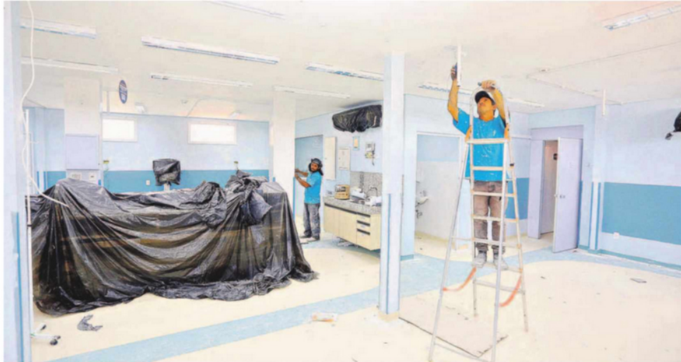
Trabalhadores se empenham nos últimos detalhes da obra: com a transferência da ala pediátrica para o novo prédio, o Hospital Dr. Mário Gatti ficará com o quarto andar disponível
