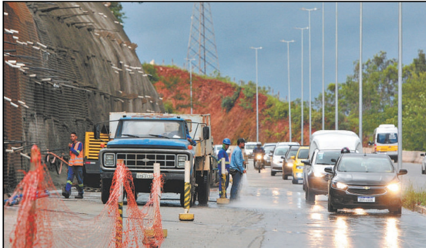
Trecho com bloqueio no Km20 da MG-030, em Nova Lima, onde houve queda de barreiras, é um dos 52 pontos de interdição no estado listados pela PMRV na sexta-feira
