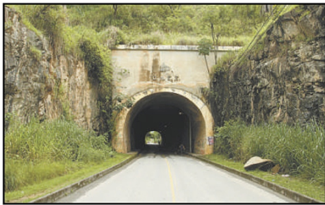
Parte de projeto ferroviário frustrado, o túnel de Capitão Eduardo terminou aberto ao tráfego de veículos
