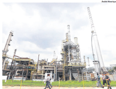
FORÇA. Braskem emprega cerca de 3.000 pessoas no Grande ABC
