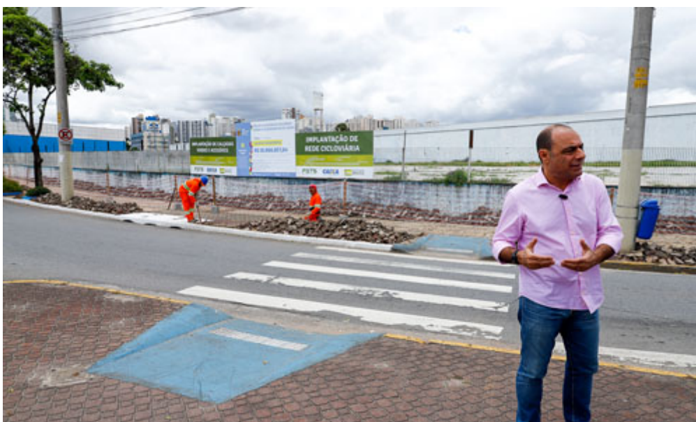
27122022 Reforma das Calçadas Av Goiás-7
