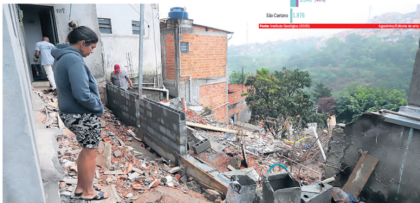
RISCO. No que sobrou do acesso à sua casa, Claudineide observa área da encosta que deslizou junto com a casa de uma vizinha; sem apoio da prefeitura, moradores removeram imóvel
