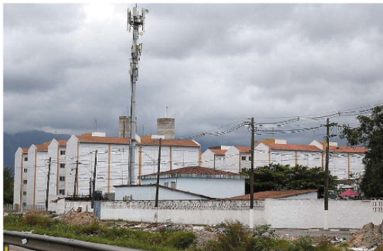
No Parque Bitaru, em São Vicente, estão ficando prontos 1.120 apartamentos para moradores de Santos
