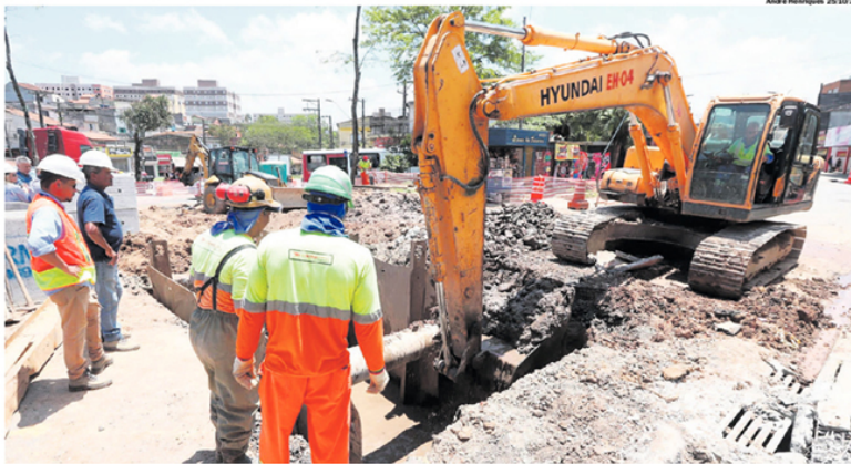
INVESTIMENTOS. Prefeituras e Estado destinam recursos a obras de drenagem e reforçam manutenção preventiva no período de chuva
