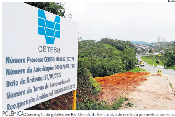
POLÊMICA. Construção de galpões em Rio Grande da Serra é alvo de denúncia por ativistas ambientais
