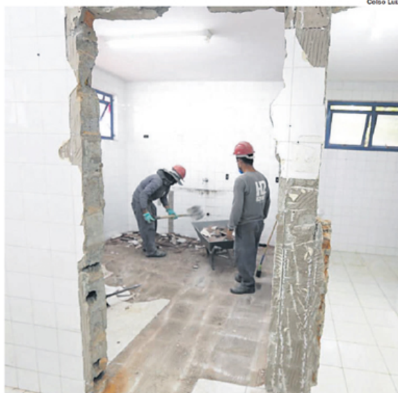
MODERNIZAÇÃO. Obras na unidade terão duração de seis meses
