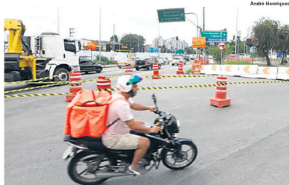
INTERDIÇÃO. Obras devem terminar apenas em julho de 2024
