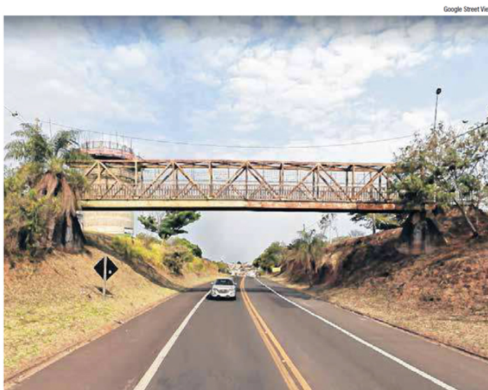
Obras na passarela da Elias Miguel Maluf, na altura da Vila Dutra, devem prosseguir até janeiro
